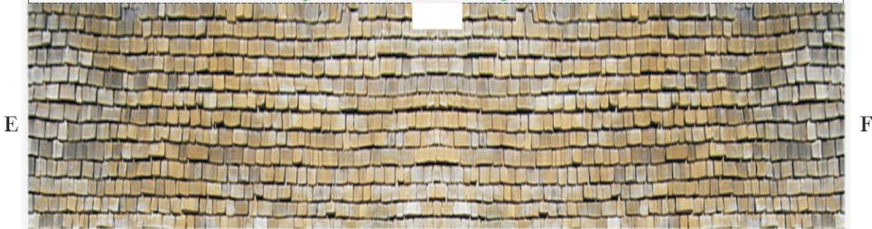
Bottom edge of Back Roof
